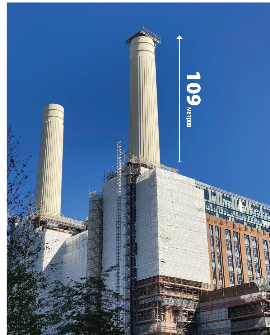
Дымовые трубы электростанции Баттерси
